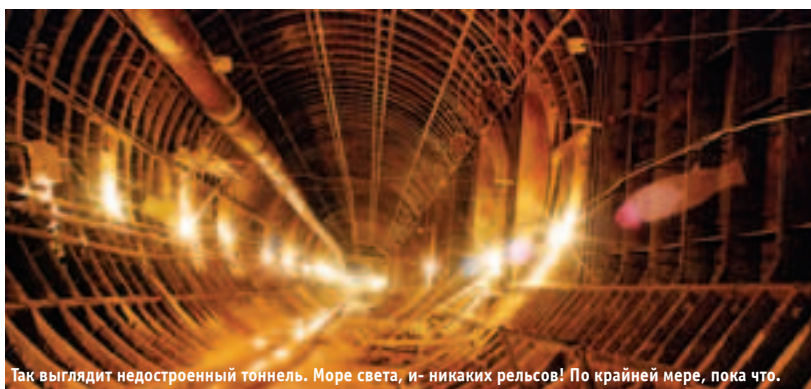
Так выглядит недостроенный тоннель. Море света, и- никаких рельсов! По крайней мере, пока что.
